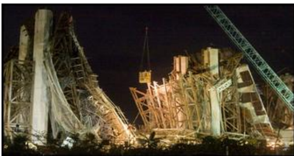
Điểm tựa (support) trên đỉnh trụ tạm T14 nằm dưới chân các sườn sắt rơi cạnh trụ P14 (Ảnh: Internet)
