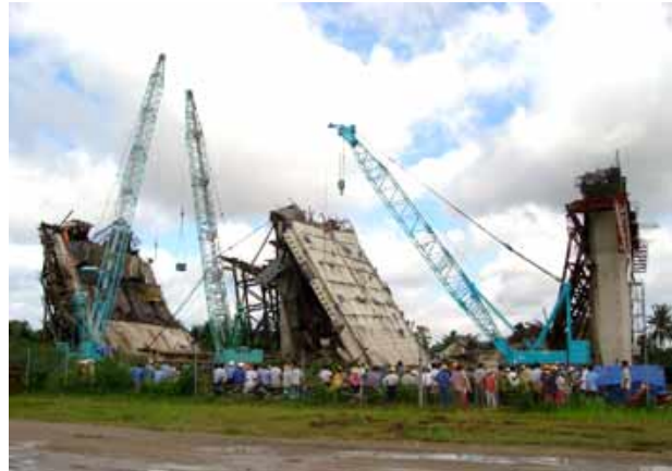
Dầm bê tông giữa trụ P13 và P14 nhìn từ hạ lưu (Ảnh: VN Express)
