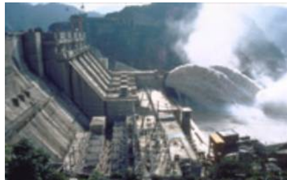
Đập thủy điện Manwan ở Trung Hoa (31)
