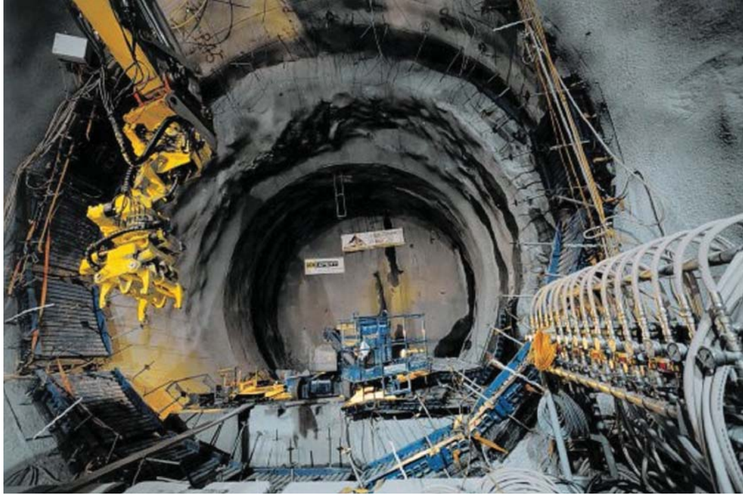
Một phần bên trong đường hầm Gotthard. Ảnh: hochtief-constructi on.com .
